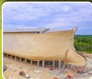
MEGACONSTRUCȚII Arca lui Noe, by WOODMIZER
