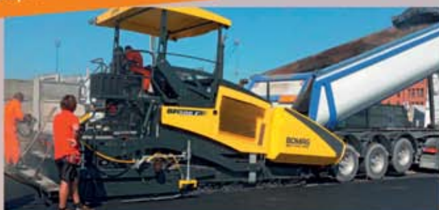
Repartizator de asfalt
