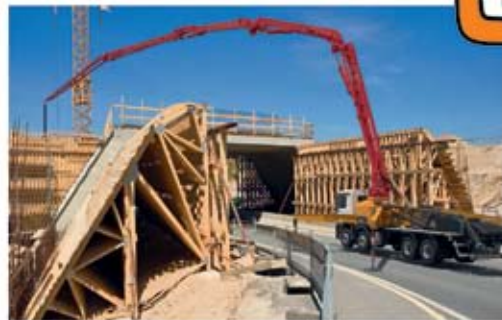
Autopompe beton și pompe mortar
